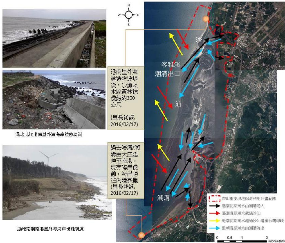
圖 4-4 本區漲潮潮水示意圖及海岸侵蝕現況照片說明
