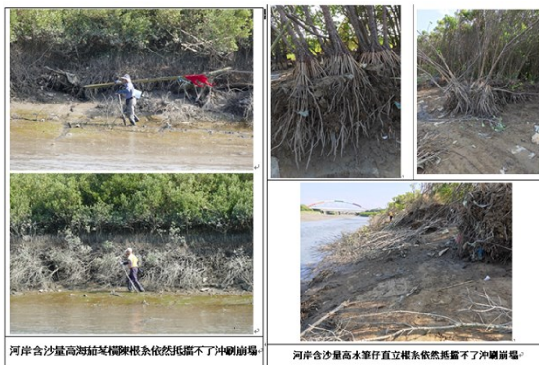
圖六：清除區河溝冲刷情形
