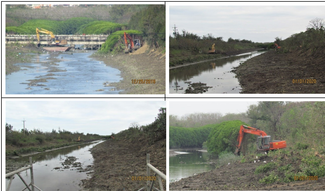
港北溝機械整治情形 圖十八：港北溝機械整治情形
