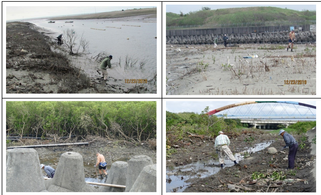
圖十六：客雅溪口人力作業情形
