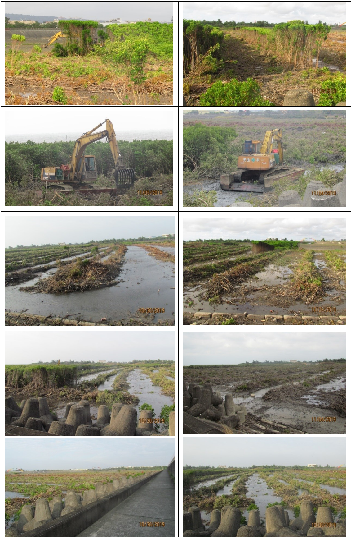
機械剷除作業情形
