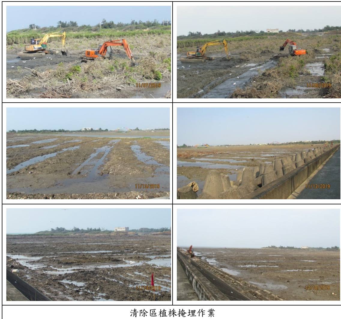
圖十四：客雅溪口南岸紅樹林整治掩埋作業情形
