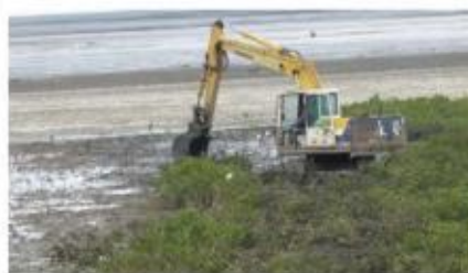
海山魚港北岸機械清除
