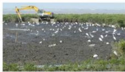
剷挖壓埋整平作業程序施作
