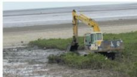
海山魚港北岸機械清除
