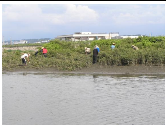
三姓溪河口南岸清除現況
