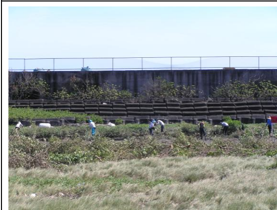
三姓溪河口北岸清除現況
