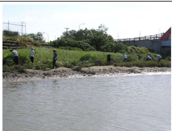
三姓溪河口北岸清除現況
