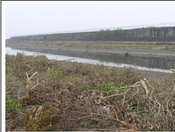
大棵植株清除後現況
