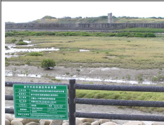
清除前清除區右+2 情形
