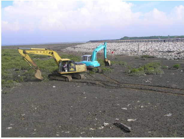
大型機械怪手二部
