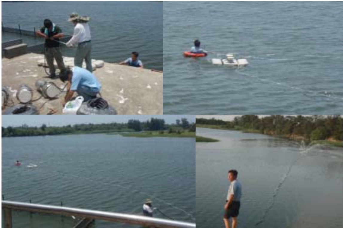
圖十四、架設水澆澆曝氣設備
