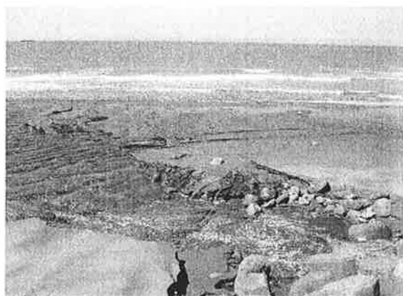
輸砂管排放口
