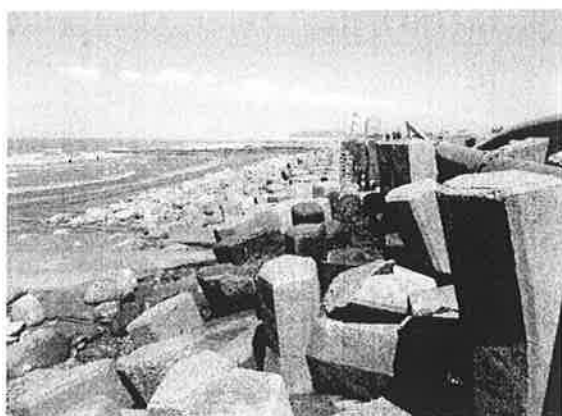
消波塊後方的迂迴供砂輸送管
