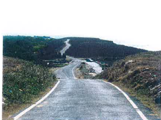
人工填埋垃圾場造成明顯高差
