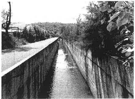
匯流入海的水泥渠道
