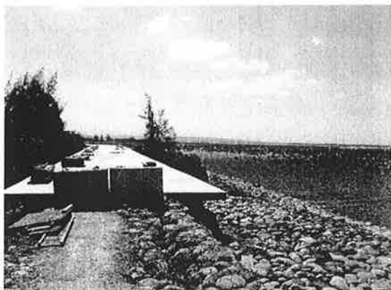
採路堤共構的自行車道
