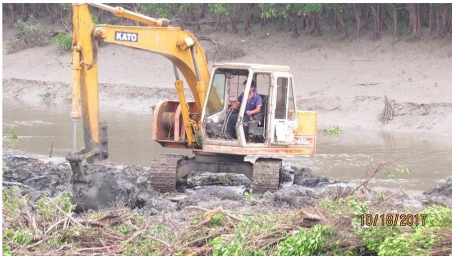
圖十八：河溝含水量高，浮筏深陷泥中無法脫困
