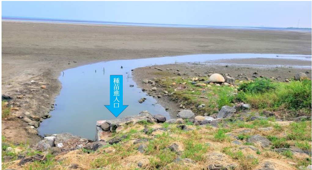
圖二十二：賞鳥公園水閘門
